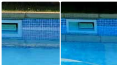
Povrch vně plaveckého bazénu
